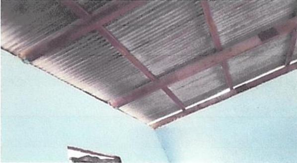
3. Cambio de cubierta de lamina y estructura de metal y pintura en muros interior y extiror de aula
